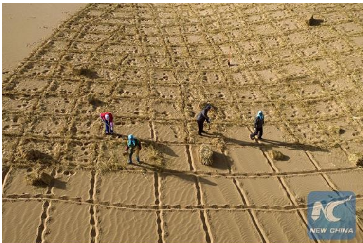
Рисунок 4. Устилочная механическая защита от подвижного песка
