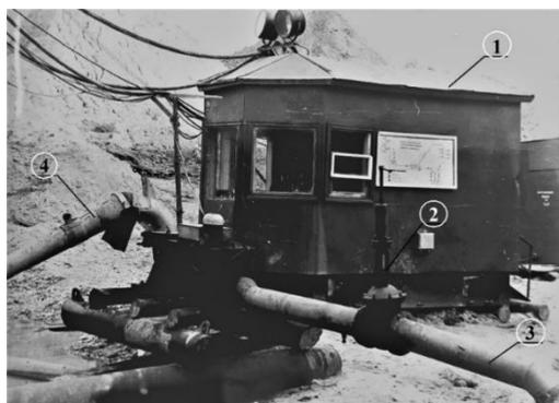
*Рис. 15. Общий вид кабины гидромониторщика. 1 – кабина; 2 – задвижка; 3 – водовод; 4 – гидромонитор ГМД-250.*
