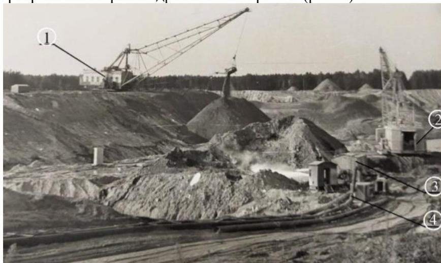
**Рис. 1.** Экскаваторно-гидравлические работы на карьере ИГОКа. Общий вид. 1 – экскаватор ЭШ-10/60 на вскрыше; 2 – экскаватор ЭШ-5/45 на добыче; 3 – размыв навала песков гидромонитором ГМД-250; 4 – измерительный блок (расходомеры, плотномеры).
