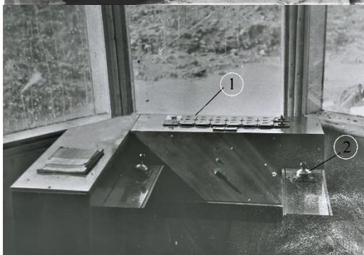
*Рис. 16. Вид из кабины гидромониторщика с пультом управления. 1 – кнопки регулирования технологическими режимами гидромониторно-грунтососной установки комплекса; 2 – рычаги управления гидромонитором.*
