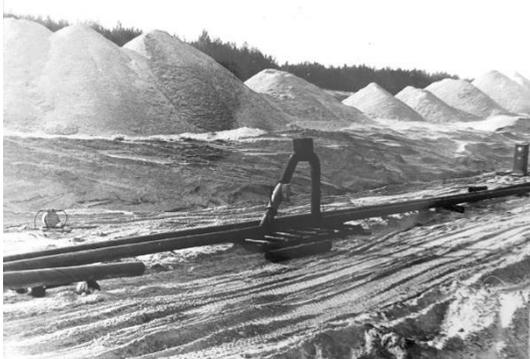
*Рис. 17. Передвижная установка измерения параметров гидротранспортирования на расстояние до 2 км из карьера на обогатительную фабрику.*
