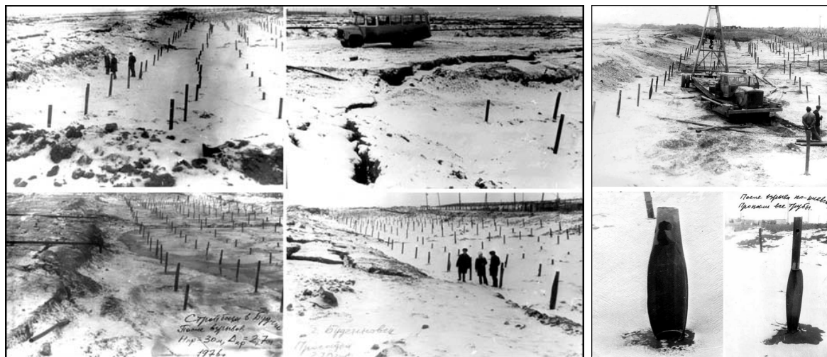
Рисунок 4.5 – Опытное гидровзрывное уплотнение просадочных грунтов на площадке стройбазы завода Пластмасс. Просадка после взрывов составила 2,75 м.
