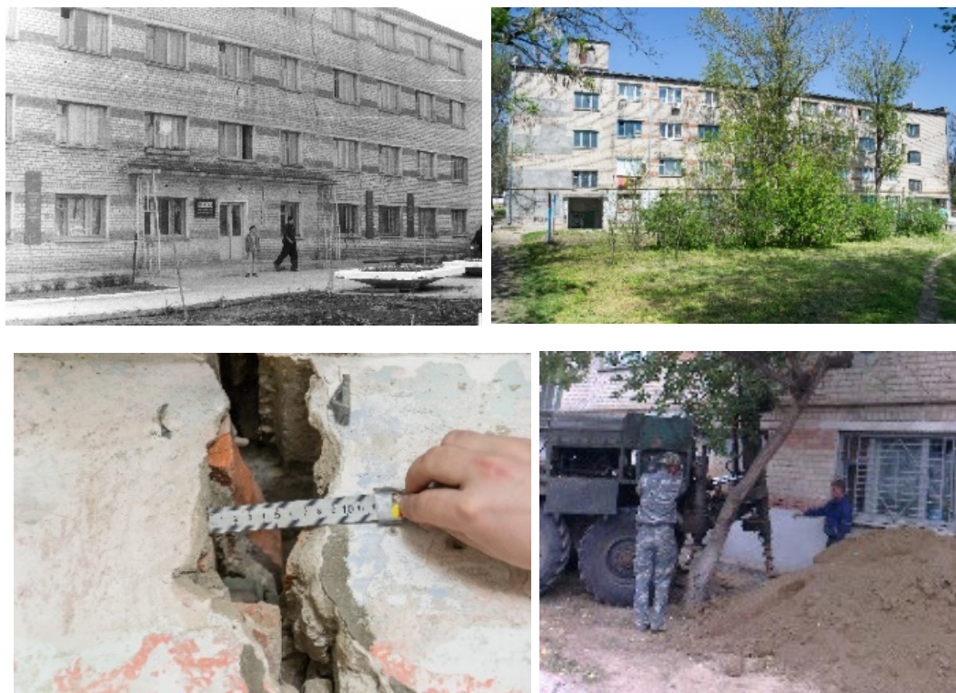
Рисунок 2.1 – Общежитие по ул. Л. Толстого, 16 и укрепление его основания грунтовыми сваями.
