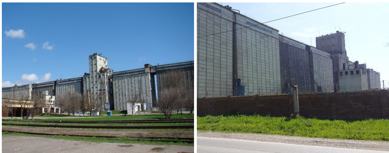
Рисунок 2.7 – Аварийные силкорпуса элеватора. Вблизи корпус комбикормового завода, где грунты уплотнили замачиванием котлованов.
