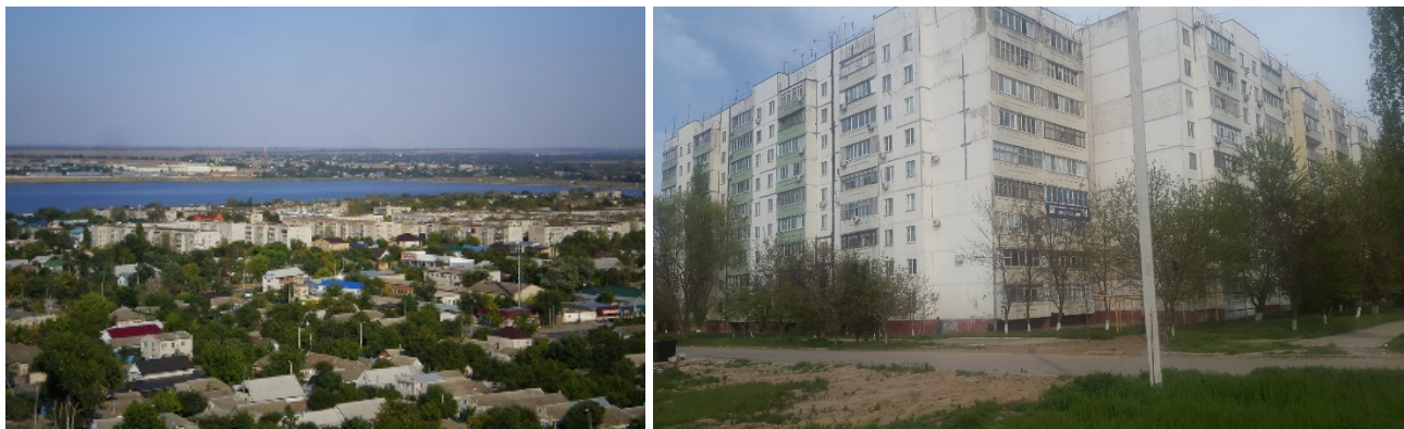
Рисунок 4.1 – Общий вид 7-го микрорайона. Вдали Буйвола и Военный городок. Жилые дома, построенные на просадочном лёссе, уплотненном глубинными взрывами и шнековыми сваями
