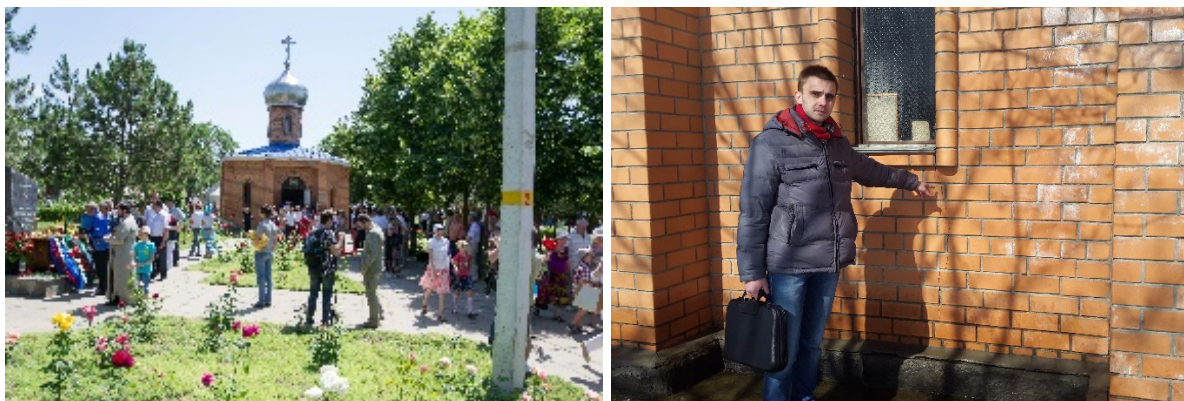
Рисунок 4.14 – Часовня Б.Н. Ельцина с трещинами.
