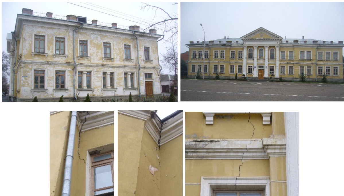
Рисунок 2.2 – Памятник архитектуры – Дом детского творчества и его деформации
