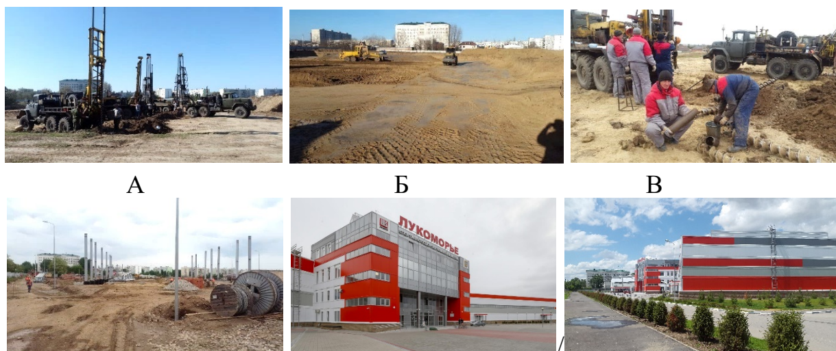
Рисунок 4.9 – Глубинное уплотнение просадочных грунтов шнековым способом и укаткой верхнего слоя на площадке строительства Спортивно-оздоровительного комплекса (Лукоморье), с отбором монолитов уплотненного грунта.
