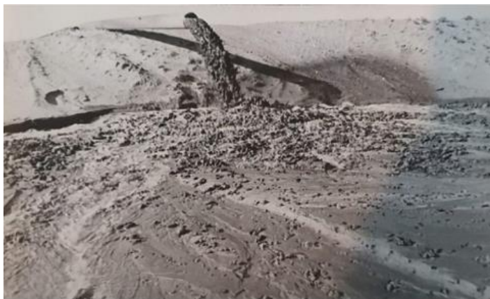
Рис. 6. Торцевой намыв пород при скорости выпуска V=3,1 м/с (расходе гидросмеси 1500 \text{ м}^3/\text{ч} )
