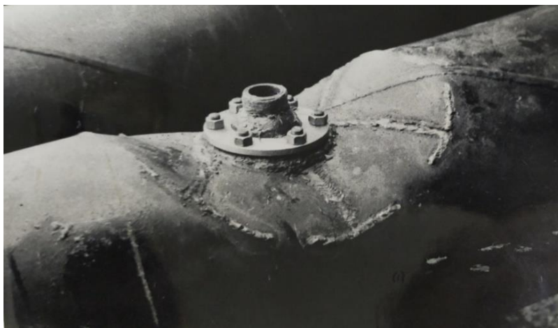
Рис.4.6. «Посадочное» место шарового датчика.
