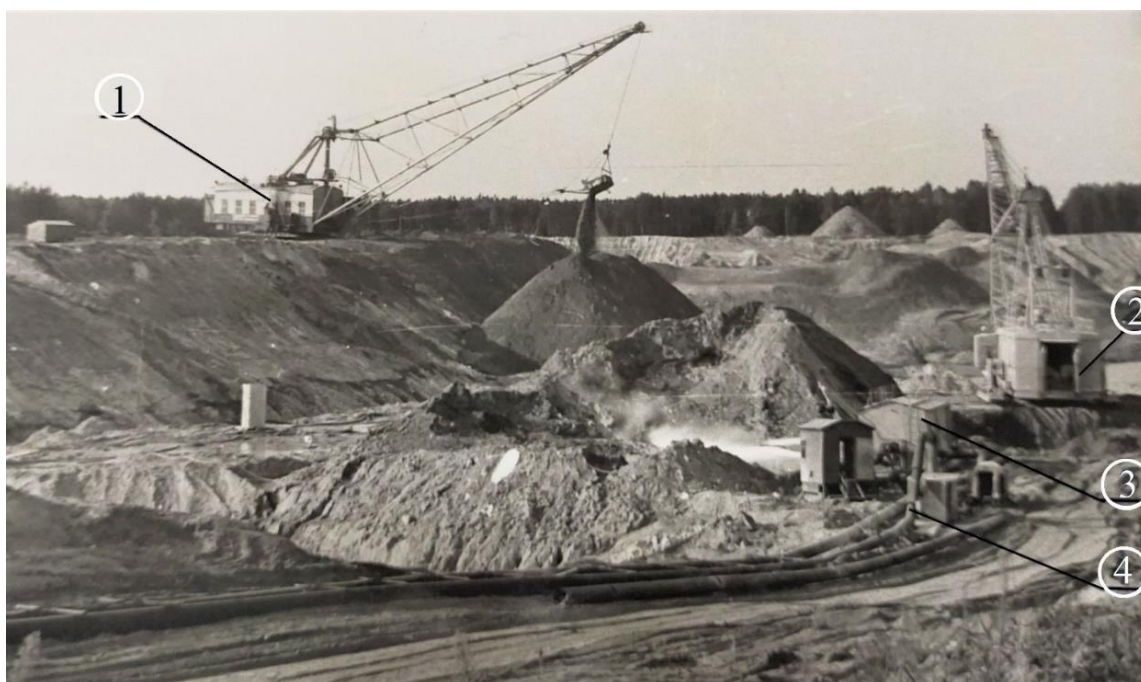
Рис.4.2. Экскаваторно-гидравлические работы на карьере ИГОКа. Общий вид. 1 – экскаватор ЭШ-10/60 на вскрышие; 2 – экскаватор ЭШ-5/45 на добыче; 3 – размыв навала песков гидромонитором ГМД-250; 4 – измерительный блок (расходомеры, плотномеры).
