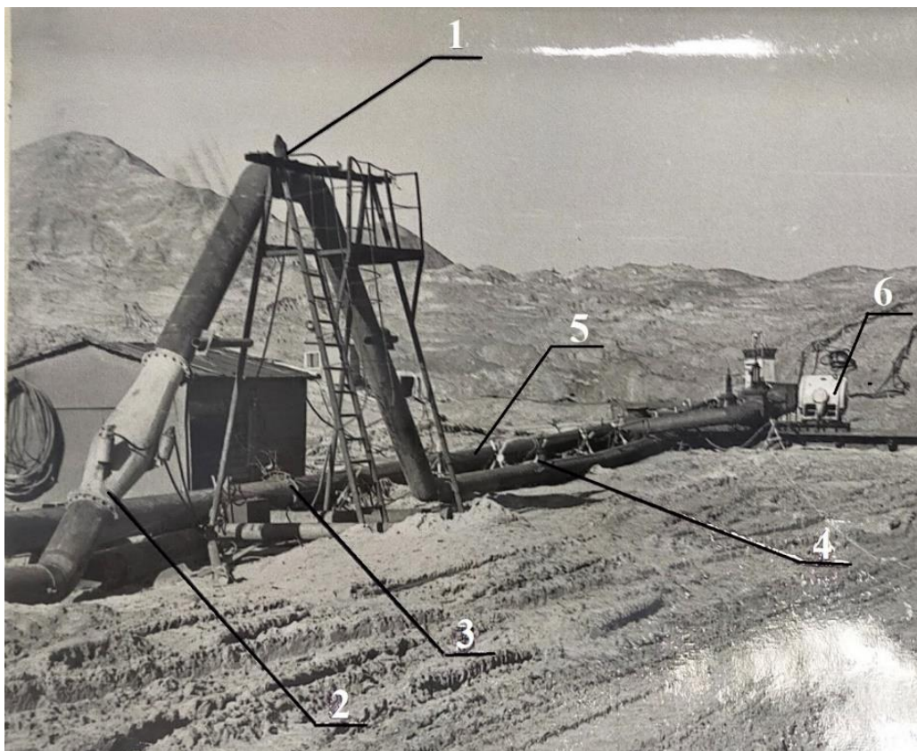
Рис.4.17. Общий вид установки системы определения расхода и плотности гидросмеси. 1 – гидростатический плотномер, 2 – расширяющее устройство расходомера гидросмеси, 3 – диафрагма ДК-25-450, 4 – пульповод D_{\text{внутр}}=410\text{мм} , 5 – водовод D_{\text{внутр}}=450\text{мм} , 6 – водяной насос 300Д-90.
