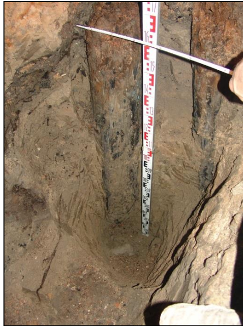
Рис. 31. Сваи со сгнившими оголовками в шурфе 14/05
