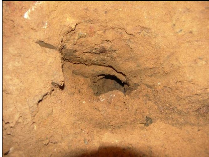
Рис. 26. Полые стаканы от сгнивших свай в песчаном грунте в шурфе 3/05
