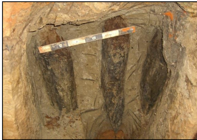
Рис. 63. Сваи со сгнившими оголовками в суглинках в основании напольной части Западной стены (шурф 53-07)
