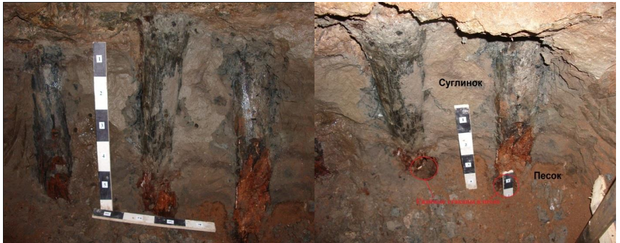
Рис. 47. Сваи в основании фундамента в шурфе 1У-05
