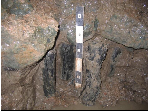
Рис. 57. Деревянные сваи под фундаментами напольной (А) и надворной (Б) части Южной крепостной стены в шурфе 1ю-07
