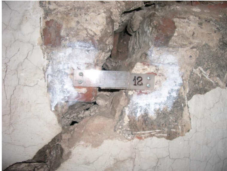
Рис. 99. Стенной маяк, установленный на трещину
