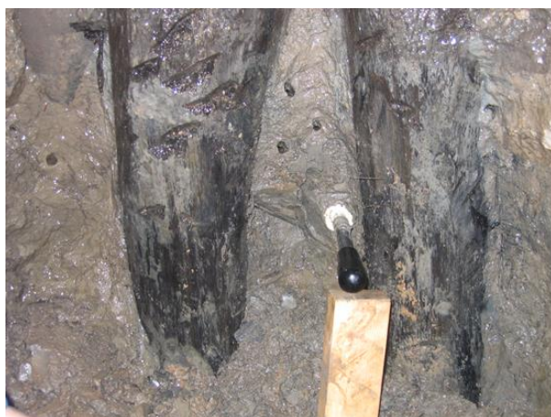
Фундамент надворной стенки
