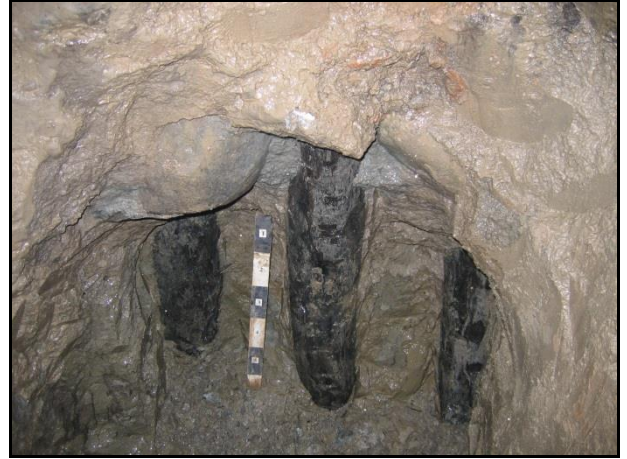
Рис. 57. Деревянные сваи под фундаментами напольной (А) и надворной (Б) части Южной крепостной стены в шурфе 1ю-07
