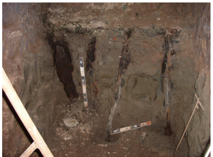
Рис. 51. Фото сгнивших свай в шурфе 9У-06
