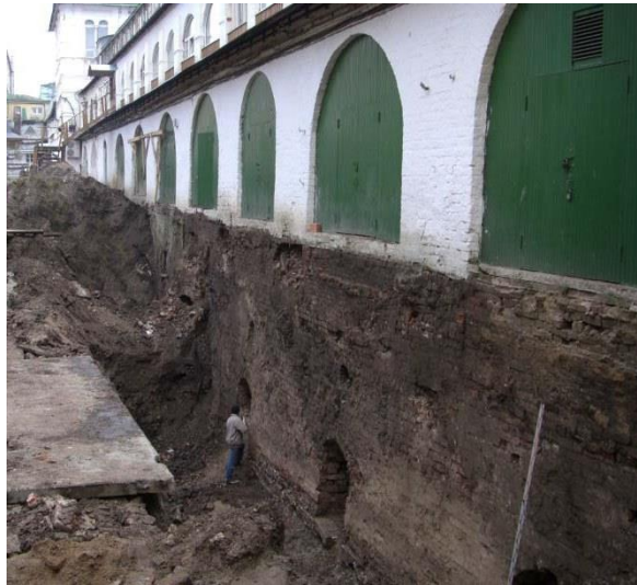
Рис.17. Вскрытие Южной крепостной стены от насыпных грунтов с внутренней стороны монастыря.
