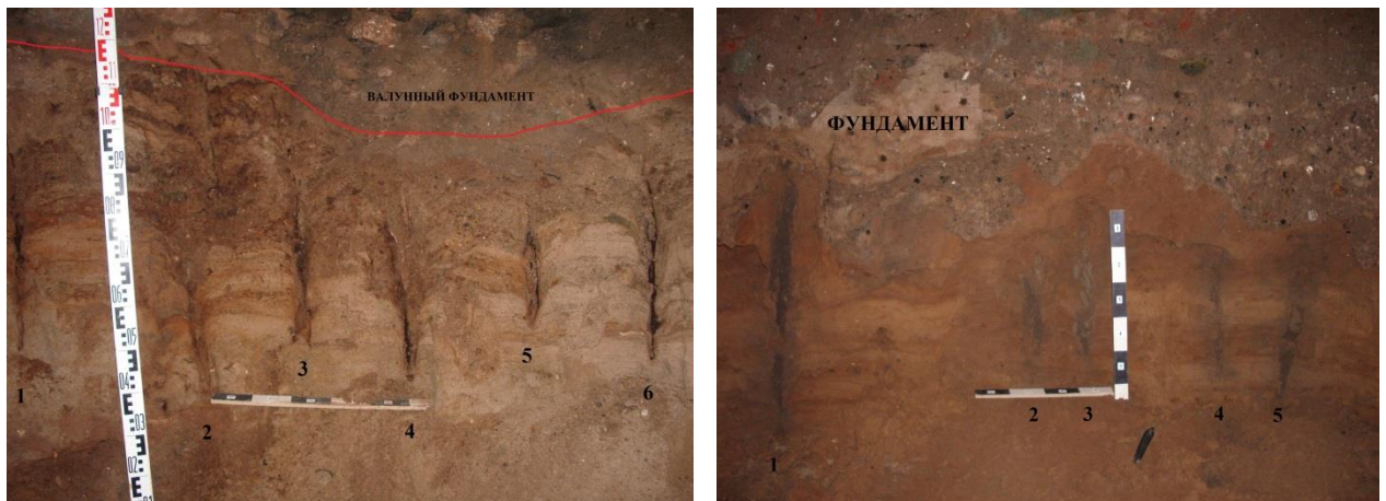
Рис. 40. Сгнившие сваи в шурфах 40К-05 и 46К-05
