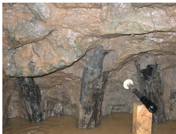
Фундамент напольной стенки
