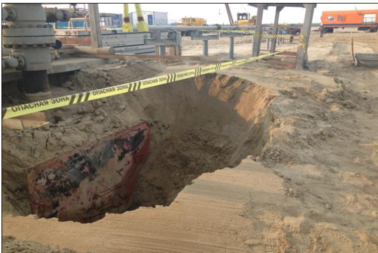
Рис. 43 – 44. Приустьевые провалы вокруг эксплуатационных скважин возникшие вследствие оттаивания ММП.
