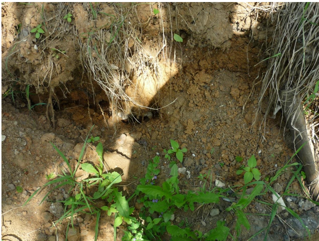
Рисунок 3.8. Трещина закола в центральной части склона.
