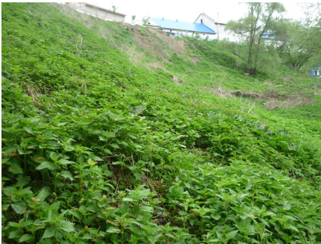
Рисунок 3.7. Оползневой рельеф склона.
